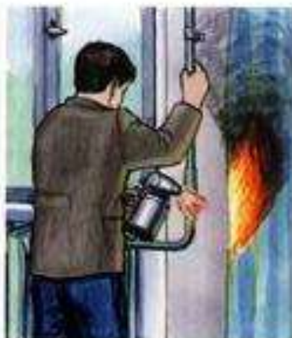
Отогревание замёрзших труб паяльными лампами и фасолами, нарушение правил проведения сварочных работ
