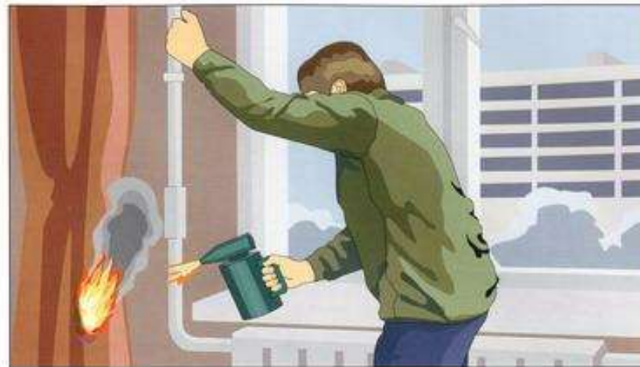
Отогревание замёрзших труб паяльными лампами и факелами
